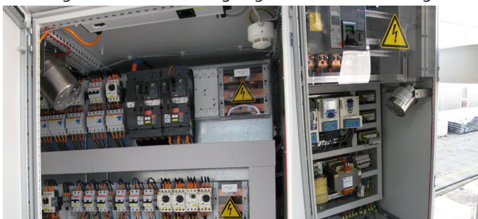
Aero-X SAFES® Schranklöschesysteme auf Basis der Stat-X® Aerosol Löschtechnik sind kompakt und können somit einfach in den zu schützenden Schränken eingebaut werden.
